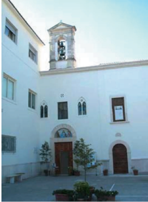
La facciata della Chiesa SS. Sacramento così come si presenta attualmente
